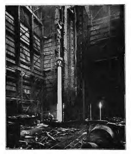
A TUBE FOR A 12-INCH GUN JUST OUT OF THE FURNACE, WHERE IT WAS TEMPERED AT WHITE HEAT AND IS NOW READY FOR QUENCHING IN THE PLANT OF THE MIDVALE STEEL CO.
