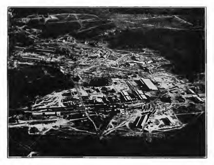
IN THE FOREGROUND THE CHLORINE PIPE LINE FROM CHLORINE PLANT PASSING TO CHEMICAL PLANTS IN RIGHT CENTER OF THE PICTURE. ON THE EXTREME RIGHT THE MUSTARD GAS PLANT. IN UPPER LEFT AND CENTER, VIEW OF FILLING PLANTS AND SHELL DUMPS.
